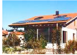
PV-Anlage Horgenzell Leistung: 1,92 kW Jahresertrag: 1.536 kWh
