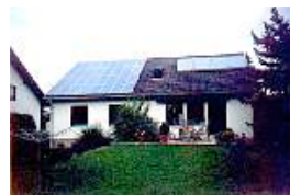
PV-Anlage Limeshain Leistung: 3,84 kW Jahresertrag: 3.072 kWh
