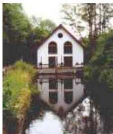
Wasserkraftanlage Feldener Mühle
