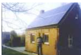
PV-Anlage Emden Leistung: 1,92 kW Jahresertrag: 1.536 kWh
