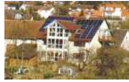
PV-Anlage Frickingen Leistung: 4,7 kW Jahresertrag: 2.112 kWh
